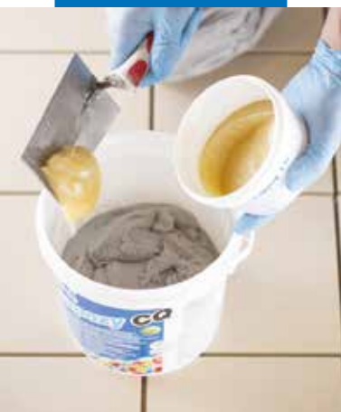
Verser le durcisseur (composant B) dans le seau du composant A
