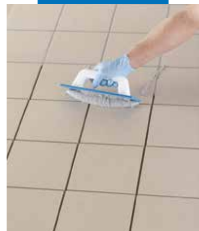
Application de Kerapoxy CQ avec la spatule en caoutchouc Mapei
