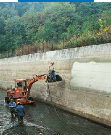
Application de Planiseal 88 par projection dans un canal hydroélectrique
