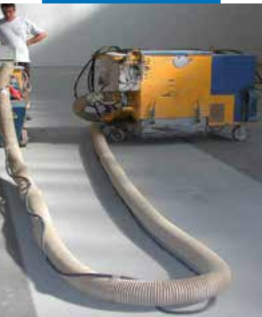
Vorbereiden van de ondergrond door kogelstralen
