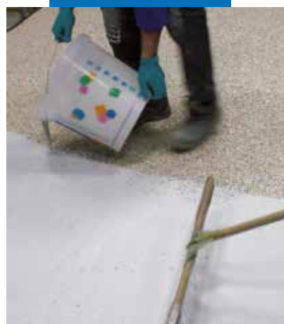
Toepassing van Ultratop op het geharde oppervlak van het mengsel uitgevoerd met natuurlijke aggregaten + Mapecfloor I 910
