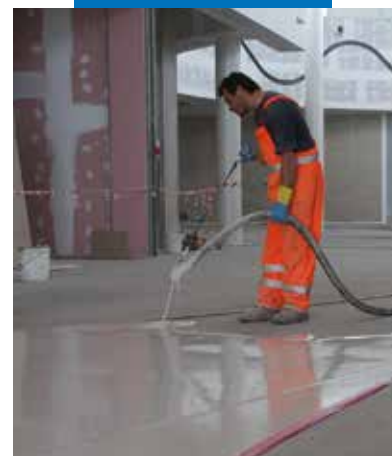
Mechanische toepassing van Ultratop met de pomp
