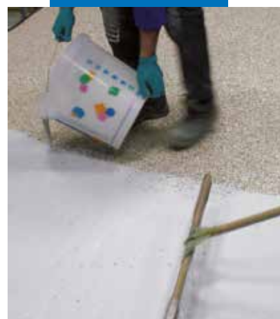
Application d' Ultratop sur la surface durcie du mélange constitué d'agrégats naturels + Mapectfloor I 910
