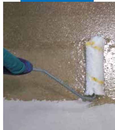
Effet "Terrazzo alla Veneziana". Application de Mapectfloor I 910
