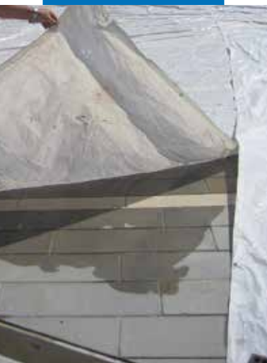
Voorbeeld van de bescherming van de vloer
