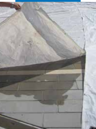
Exemple de protection de sol
