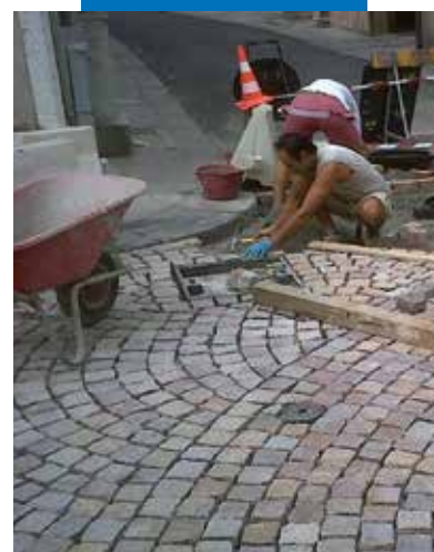
Exemple de pose de pavage en arche
