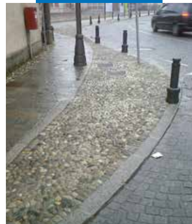
Exemple de sol en pavés, dalles et de pavés de porphyre
