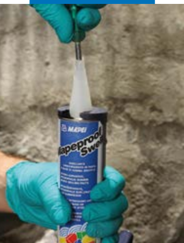
Doorboren van het beschermende membraan op de Mapeproof Swell koker
