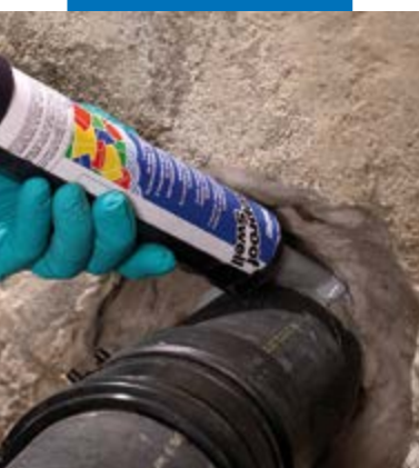
Aanbrengen van Mapeproof Swell rondom een leiding
