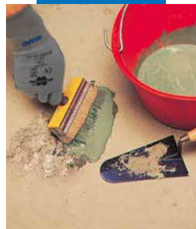
Vloer opvulling: aanbrengen van de aanbrandlaag
