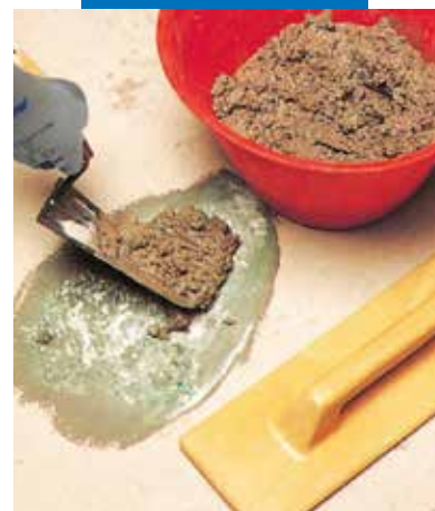
Vloer opvulling: aanbrengen van de mortel
