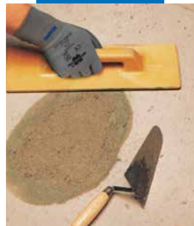
Vloer opvulling: afwerking van de opvulling
