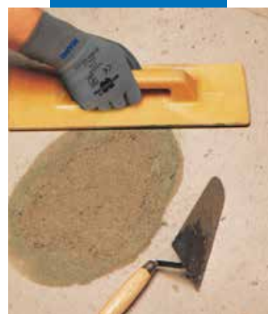
Réparation d'une chape: lissage final
