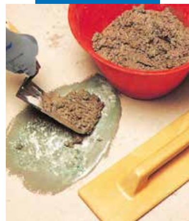
Réparation d'une chape: application du mortier
