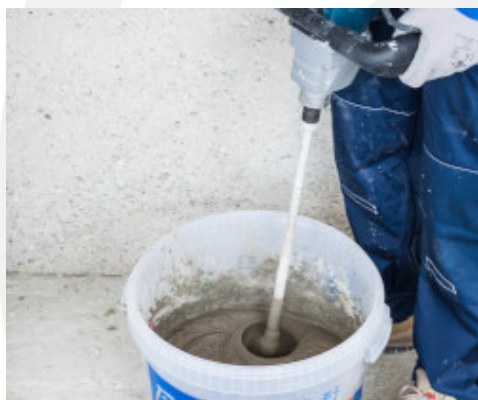
Mengen van Planitop Rasa & Ripara R4 Zero
