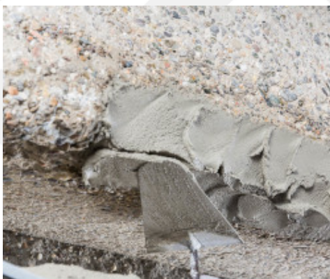
Aanbrengen van Planitop Rasa & Ripara R4 Zero
