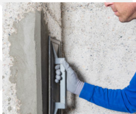
Gladstrijken van Planitop Rasa & Ripara R4 Zero
