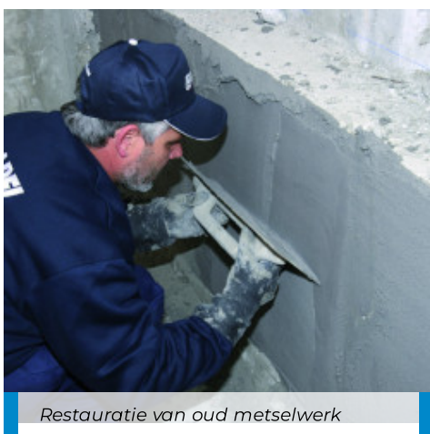
Uitvlakken van Nivoplan met een reilat
