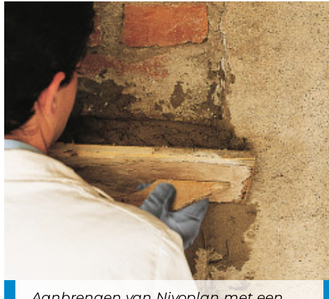
Aanbrengen van Nivoplan met een strijkbord
