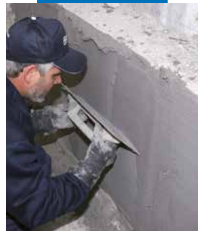
Application de Nivoplan avec une taloche
