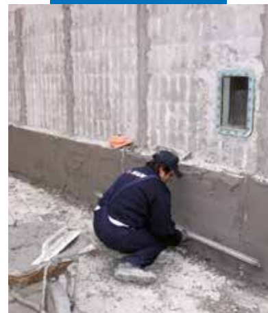
Mise à niveau de Nivoplan avec une règle
