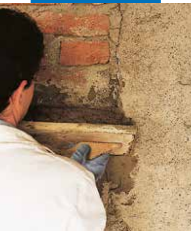
Restauration de maçonnerie ancienne
