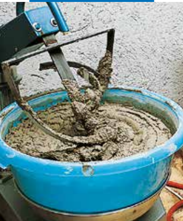
Mélange avec une petite bétonnière
