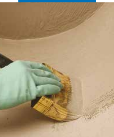
Imperméabilisation de surfaces à la brosse
