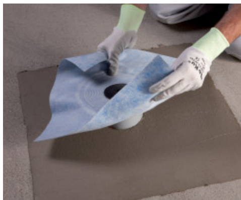
Aanbrengen van een verticale afvoer op Mapelastic Zero
