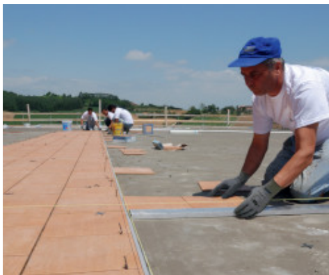
Aanbrengen van keramiek met Kerabond + Isolastic
