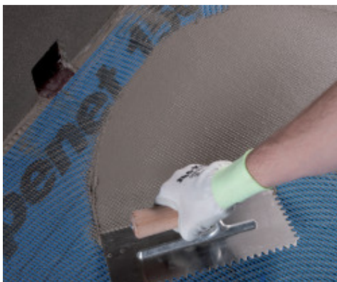
Aanbrengen van Mapelastic Zero op Mape-net 150
