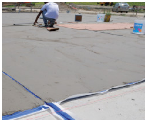
Waterdicht maken van dekvloeren met Mapelastic Zero Mapeband
