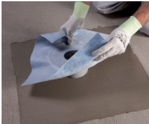
Application d'un drain vertical sur Mapelastix Zero
