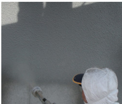
Exemple d'application de Mapelastix Zero par projection sur un viaduc
