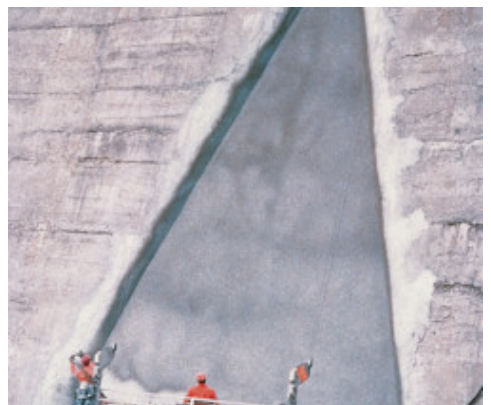
Exemple d'application de Mapelastix Zero par projection sur un barrage
