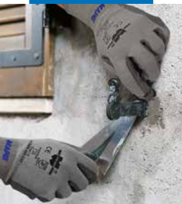
Fixation de gonds et d'arrêts de volets avec Lampocem
