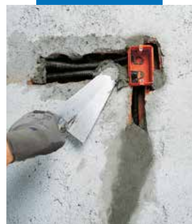
Fixation de boîtiers et gaines de câbles électriques en utilisant Lampocem
