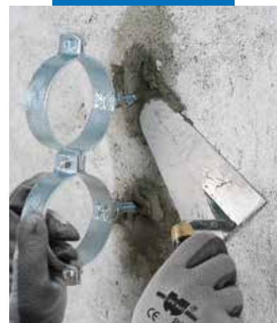
Fixation de colliers pour canalisations en utilisant Lampocem
