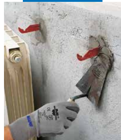
Fixation des supports de radiateurs en utilisant Lampocem
