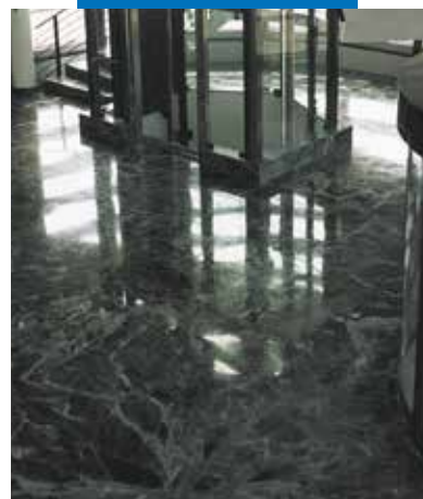
Sol en marbre vert des Alpes dans le hall du bâtiment Rolex (Bienne - Zwitterland)
