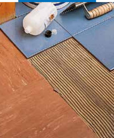
Pose sur un vieux sol en PVC
