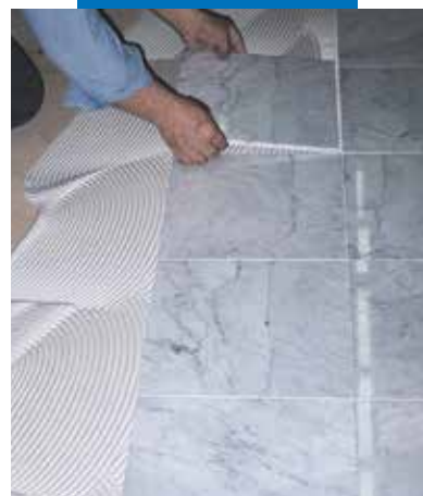
Installation de marbre de Carrare sur un support de bois avec du Keralastic blanc
