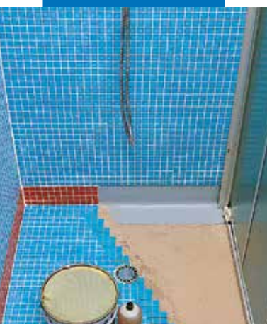
Imperméabilisation et pose d'une cabine de douche préfabriquée
