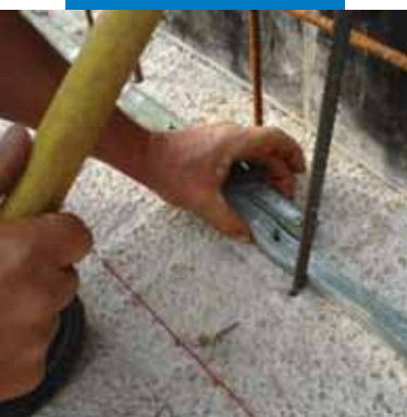
Recouvrement des profilés au niveau des jonctions
