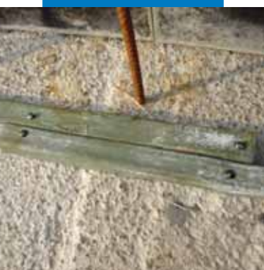
Recouvrement des profilés au niveau des jonctions
