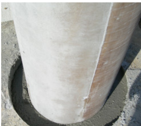
Verankeren van een prefab pijler
