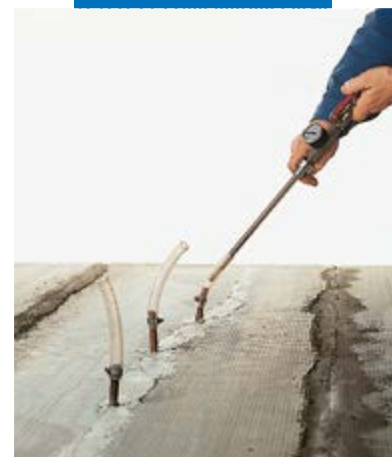
Repareren van balken door injecteren met Epojet
