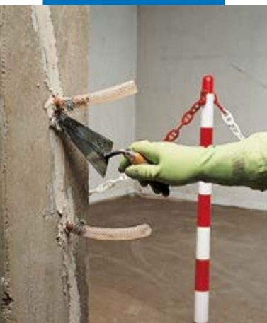
Vastzetten van injectiepijpen met Adesilex PG1
