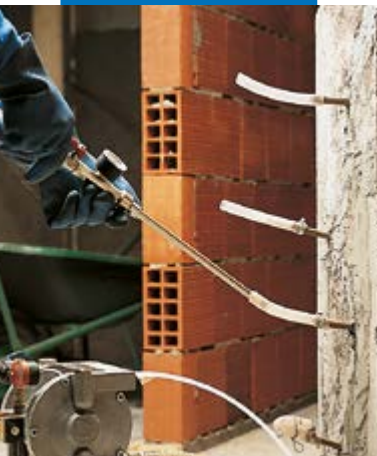
Injecteren van Epojet in gescheurde pijlers
