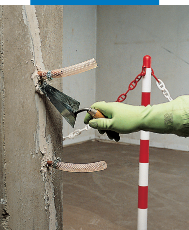
Fixation des tubes à injection avec Adesilex PG1
