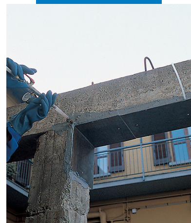
Réparation d'une poutre par injection d'Epojet
