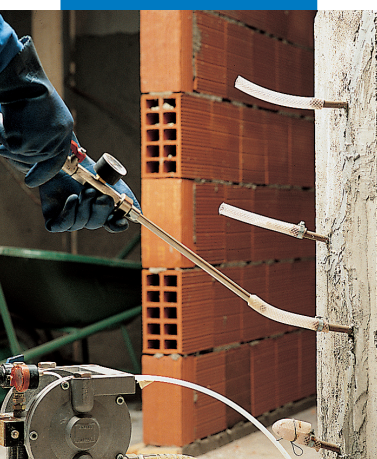
Injection d'Epojet dans les piliers fissurés
