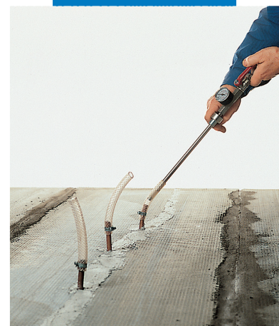
Réparation d'une structure horizontale par injection d'Epojet
