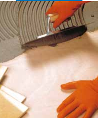
Met Elastorapid aanbrengen van gres porcellanato op watervaste multiplex
