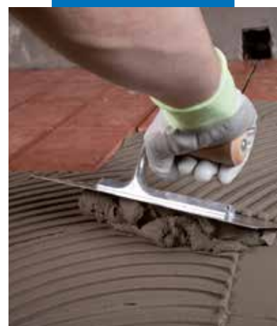
Aanbrengen van Granirapid op een terras dat waterdicht is gemaakt met Mapelastic
