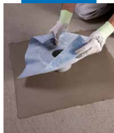
Aanbrengen van een verticale afvoer op Mapelastic
