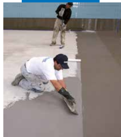
Waterdicht maken van een zwembad met Mapelastic
