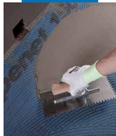
Het aanbrengen van Mapelastic op Mapenet 150
