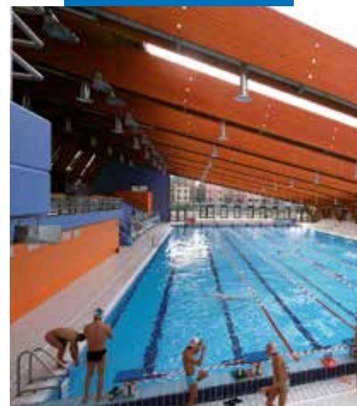
Piscine imperméabilisée avec Mapelast - Piscine Scarioni - Milan - Italie
