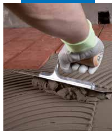
Application de Granirapid sur une terrasse imperméabilisée avec Mapelastic
