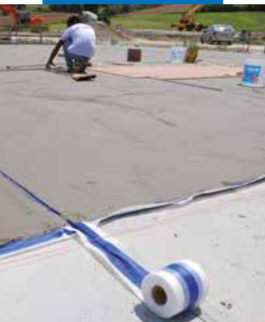
Imperméabilisation de chape avec Mapelastic et Mapeband
