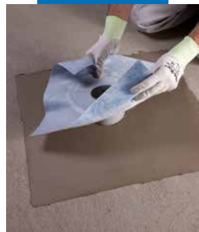
Application d'un drain vertical sur Mapelastic
