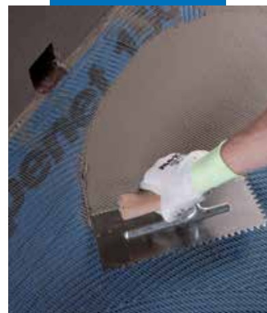
Application de Mapelastic sur Mapenet 150
