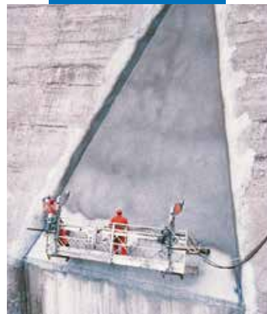
Exemple d'application de Mapelastick par projection sur un barrage
