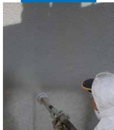
Exemple d'application de Mapelastick par projection sur un viaduc
