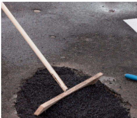
Aanbrengen en verspreiden van Mape-Asphalt Repair 0/8
