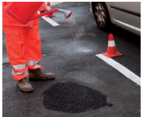
Bevochtigen van het oppervlak van Mape-Asphalt Repair 0/8
