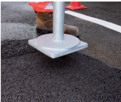
Verdichting van Mape-Asphalt Repair 0/8 met de hand
