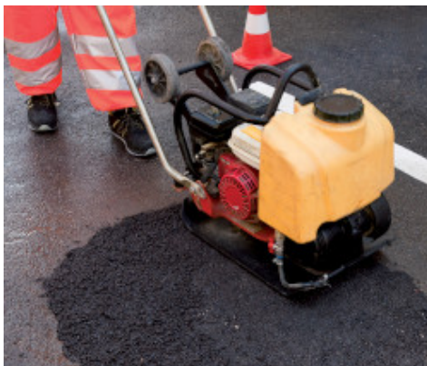
Verdichting van Mape-Asphalt Repair 0/8 met een trilplaatverdichter
