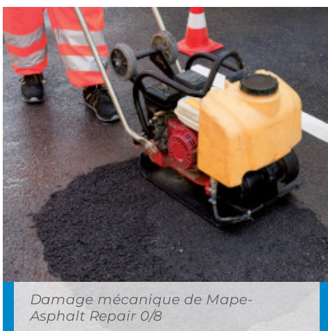
Application et étalement de Mape-Asphalt Repair 0/8
