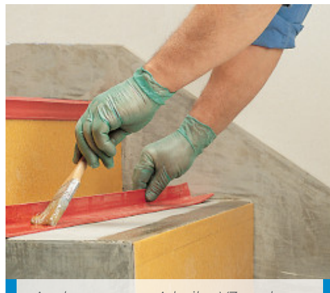
Aanbrengen van Adesilex VZ op de rug van een trapneus van PVC
