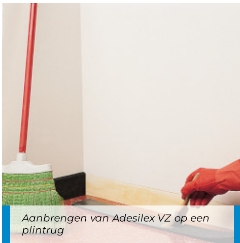
Verlijming van PVC plinten
