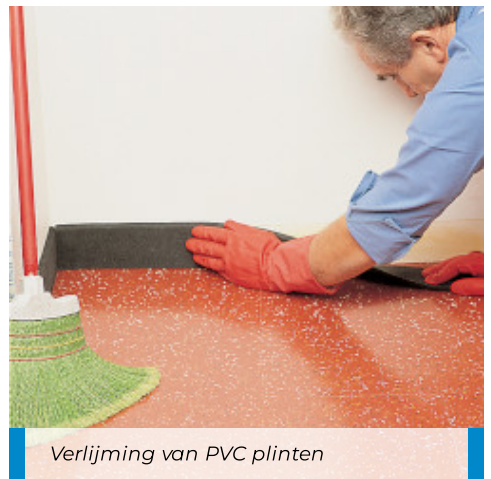
Aanbrengen van Adesilex VZ op een plintrug
