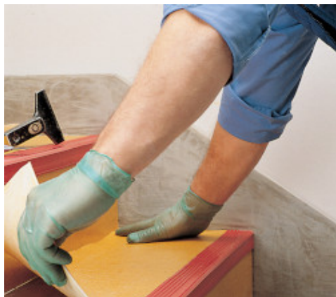
Aanbrengen van PVC op een trap
