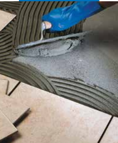
Pose de carrelage monocousson au sol
