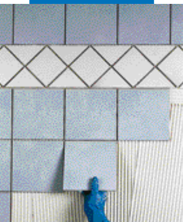
Pose de carrelage monocousson sur un mur de plaque de plâtre
