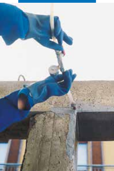
Met Adesilex PG1 gefineerde balken
