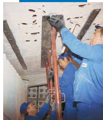
Uitsmeren van Adesilex PG1 op metaalplaat
