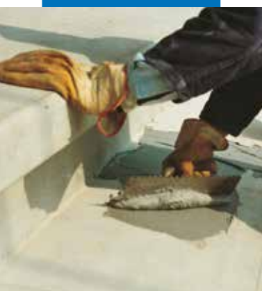
Met een getande spatel uitsmeren van Adesilex PG1 voor structureel verlijmen van geprefabriceerde traptreden
