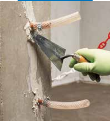
Vastzetten van injectiepijpen en stucen van de scheuren tijdens de versterking van de structuur
