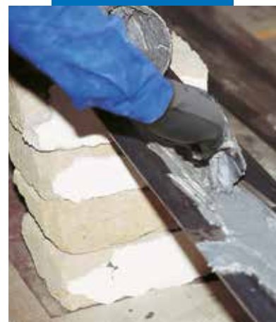
Uitsmeren van Adesilex PG1 op metaalplaat
