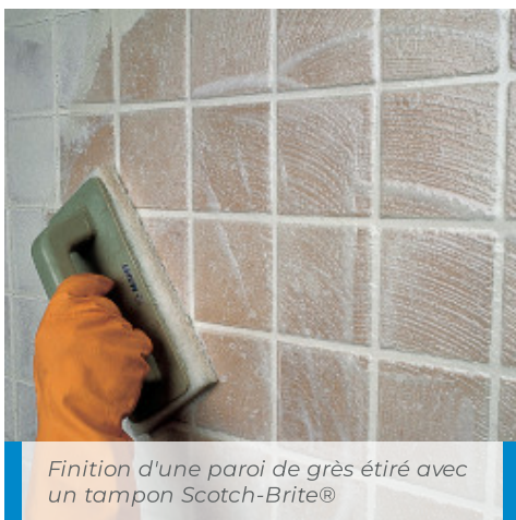
Finition d'un mur de grès étiré avec une éponge
