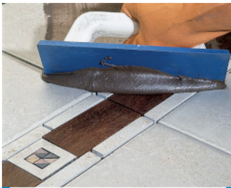
Jointoiement, à la spatule, de carrelage céramique avec insertion de bois
