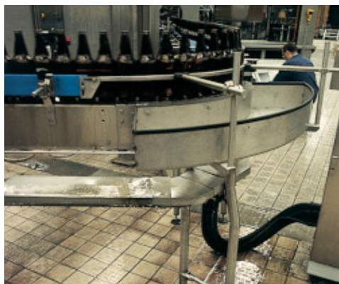
Exemple de jointoiement dans une brasserie
