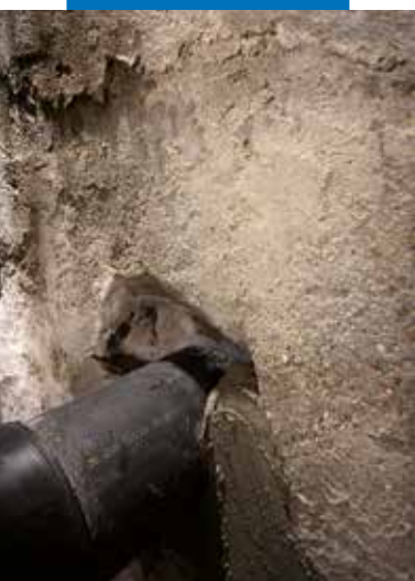
Confinement de Mapeproof Swell avec Mapegrout T 40
