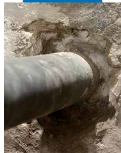
Démolir la structure autour du tube
