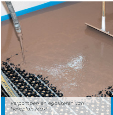
Aanbrengen van het mengsel over een volledig in te bedden compact verwarmingssysteem
