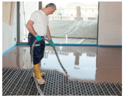
Aanbrengen van het mengsel over een volledig in te bedden compact verwarmingssysteem
