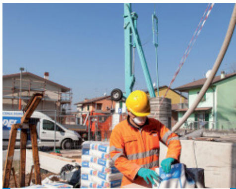
Bereiden en verpompen van het Novoplan Maximengsel met een continu mengende pomp
