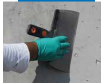
Verwijdering van onregelmatigheden met een spaan
