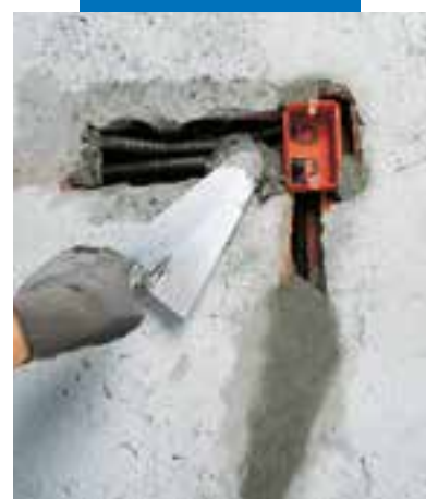
Bevestigen van elektriciteitsdozen en -leidingen met Lampocem
