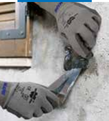
Bevestigen van ankerbouten voor ramen met Lampocem
