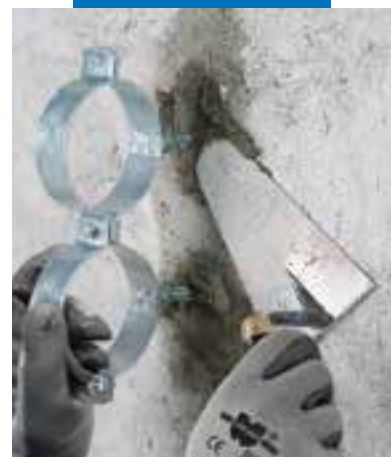
Bevestigen van pijpbeugels met Lampocem
