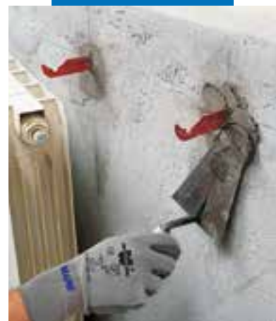
Bevestigen van ankerbouten voor radiators met Lampocem
