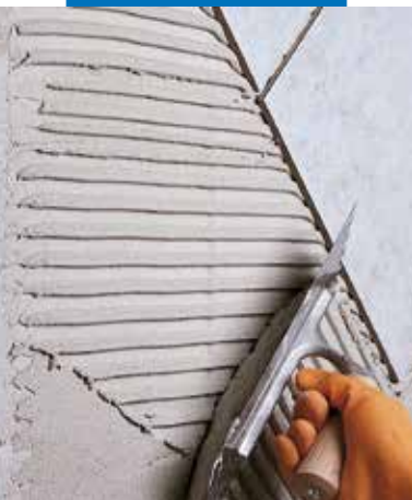
Betegelen van wanden in cellenbetonblokken
