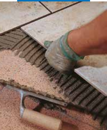
Betegelen van bestaand terrazzo op een buitenwand
