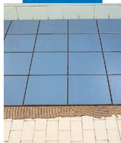
Betegelen van bestaand keramisch tegelwerk met Keraflex grijs
