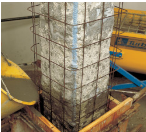
Gieten in een bekisting
