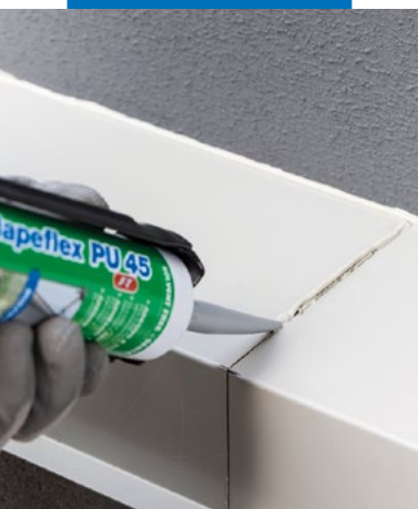
Elastisch afdichten van constructievoegen
