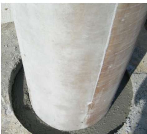
Ancrage de pilier préfabriqué
