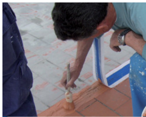
Imperméabilisation d'un joint de distribution avec Mapeband encollé en place avec Aquaflex Roof
