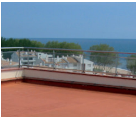
Toit plat imperméabilisé avec Aquaflex Roof
