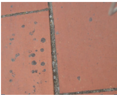
Exemple d'ancien sol en terracotta nécessitant un traitement l'application d'Aquaflex Roof
