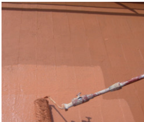
Application d'Aquaflex Roof avec un rouleau à poils longs
