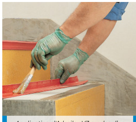
Application d'Adesilex VZ au dos d'un nez de marche en PVC
