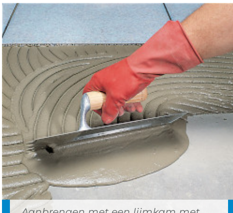
Aanbrengen met een lijmkam met halfronde tanden
