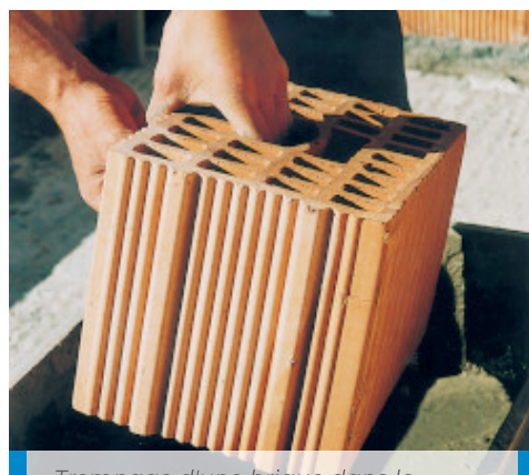
Trempage d'une brique dans le mortier Adesilex P4
