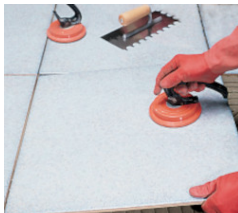
Pose de carreaux de grands formats
