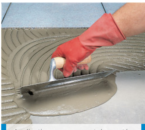
Application avec une spatule crantée semi-ronde
