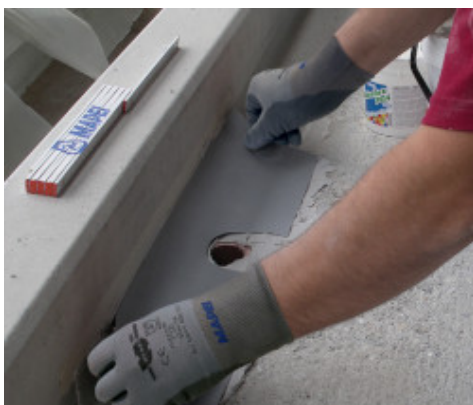
Aanbrengen van een flexibele Hypalon-strip
