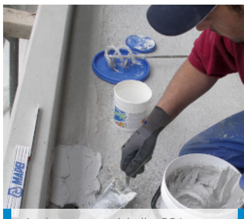
Aanbrengen van Adesilex PG4 met een spaan
