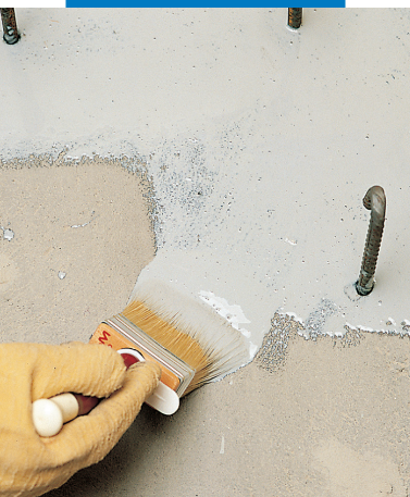
Application d'Eporip au pinceau sur des reprises de bétonnage
