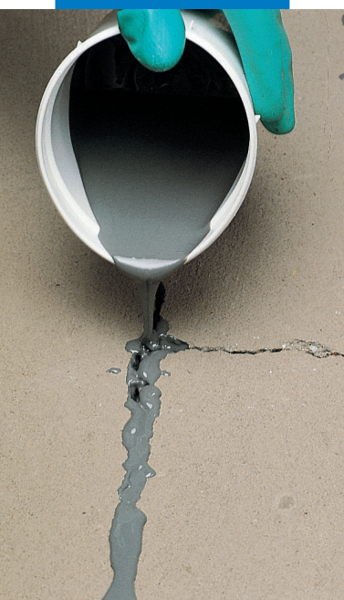
Réparation de fissures dans une chape ciment avec Eporip
