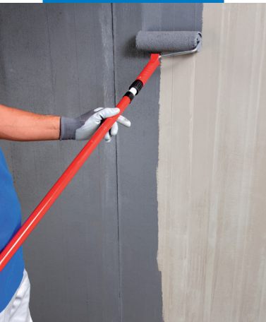
Application d'Eco Prim Grip Plus au rouleau sur du béton
