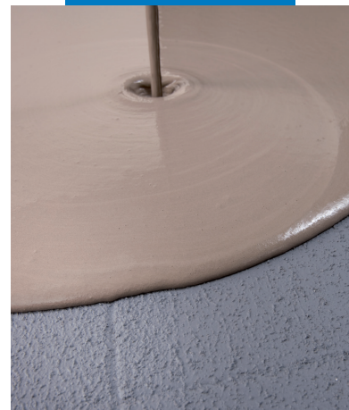
Application d'un lissage autonivelant sur Eco Prim Grip Plus sec et appliqué sur un sol ancien
